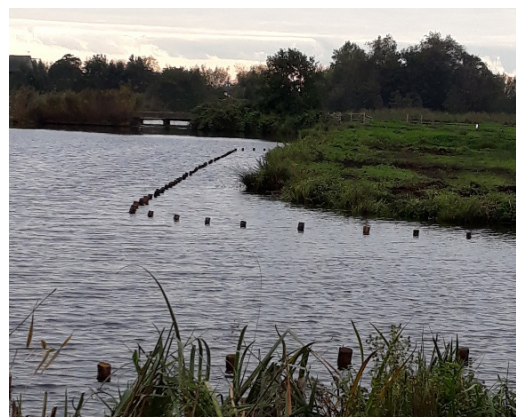
Ook werden enkele slootkanten hersteld, achter de palen wordt nog slootschoonsel aangebracht.
