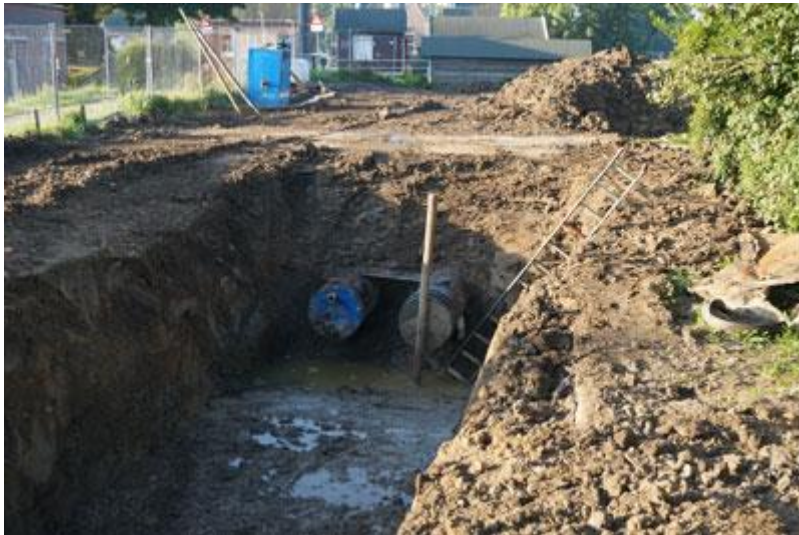
De persleidingen liggen in de grond
