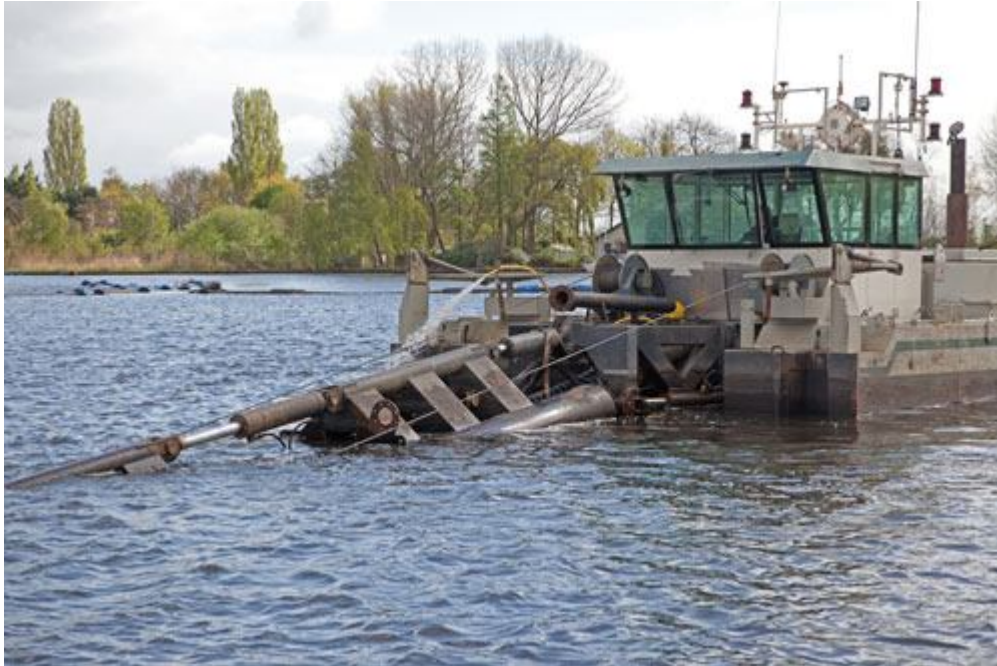
De baggerzuiger aan het werk
