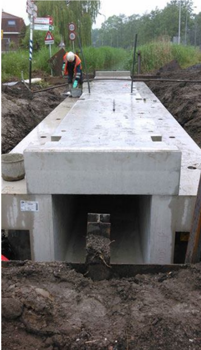
Vervangen van de duiker bij de Goudvlinderstraat
