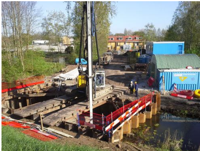
Heiwerkzaamheden voor het gemaal aan de Goejanverwelledijk
