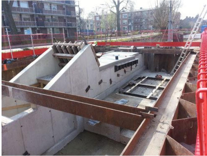
De bouw van het gemaal aan de Achterwillensweg
