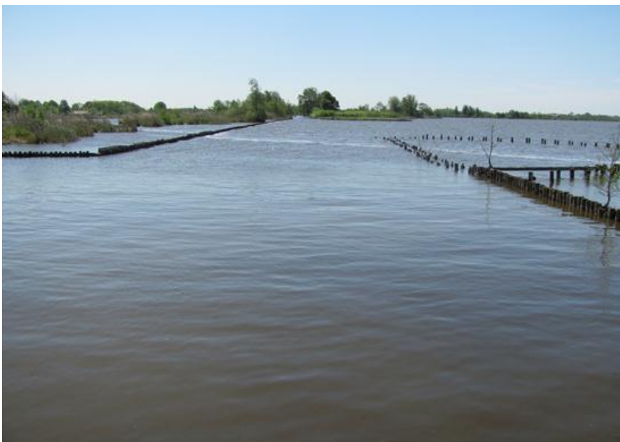
Afbeelding 7: Resterende beschoeiing van eerdere herstelwerkzaamheden
