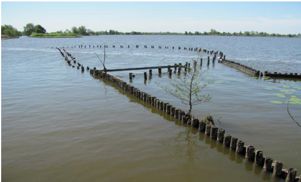
Afbeelding 12: Zuidkant van het eiland 'De Rode schuur' geplaatste beschoeiing met verdwenen land en ontstane drijfbladvegetatie.
