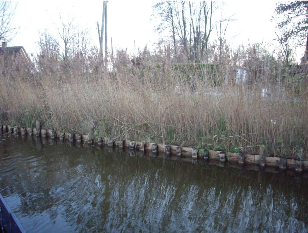
Afbeelding 14: Resultaat constructie volgens de WATERSNIP LEGAKKERCONSTRUCTIE ©
