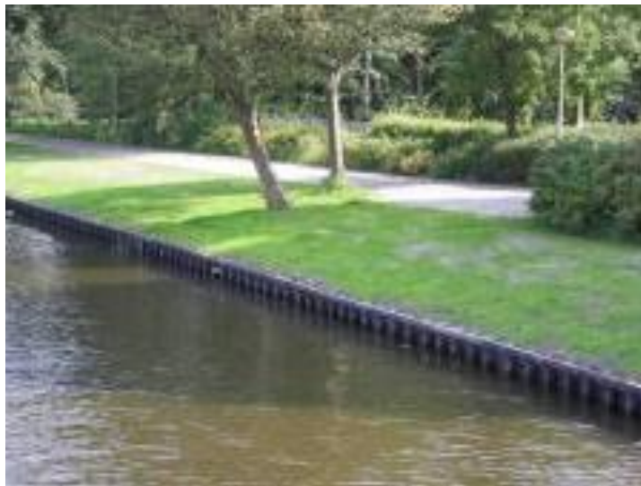
Afbeelding 16: paal met kunststof kop, impressie beschoeiing met palen met kunststof kop
