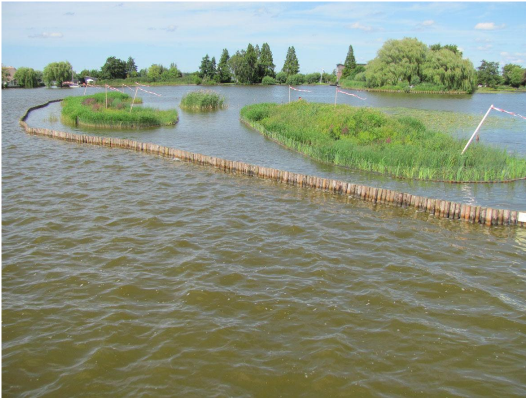
Afbeelding 17: Voorbeeld golfbreker middels aaneengesloten rij palen.
